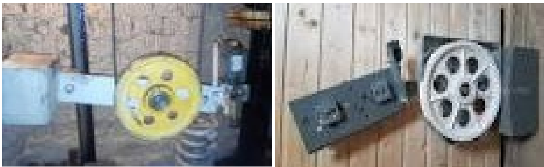
Şəkil 3.4. Sürət məhdudlaşdırıcı kanat (maşın şöbəsində və liftin çalasında)
