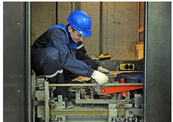
Şəkil 2.2. Lift elementlərinin sazlanması
