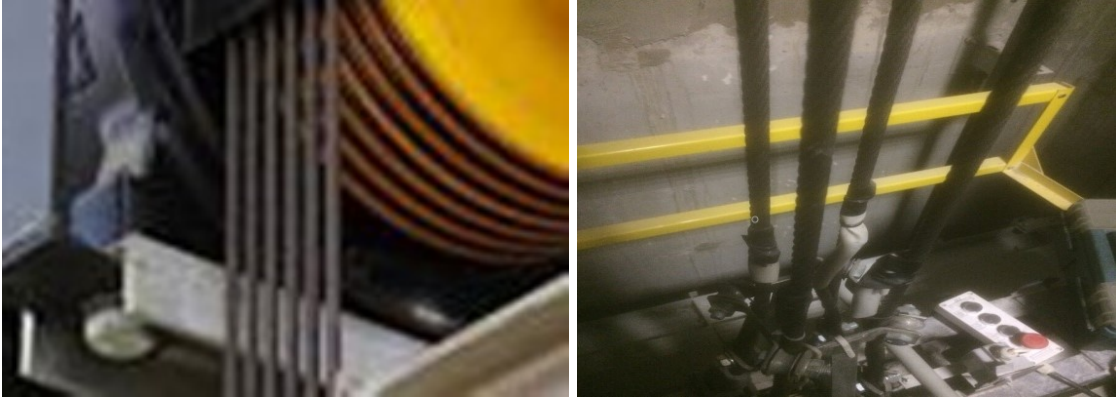
Şəkil 3.3. Əsas kanatlar (solda - şaxtada olan kanatlar, sağda - maşın şöbəsində)
